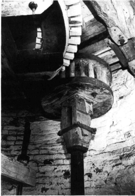
Afb. 59. spoorwiel, rondsel en staakijzer in bergmolen De Welvaart te Horn
