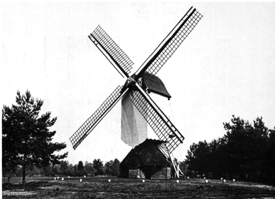
Afb. 13. de standermolen te Overpelt met onder de molenkast het molenkot of de paraplu
