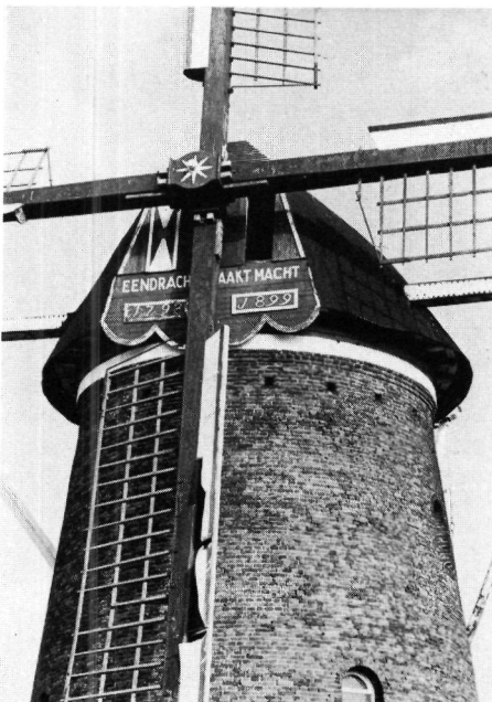
Afb. 28. askop, baard en windluiken van de molen Eendracht maakt macht te Horst
